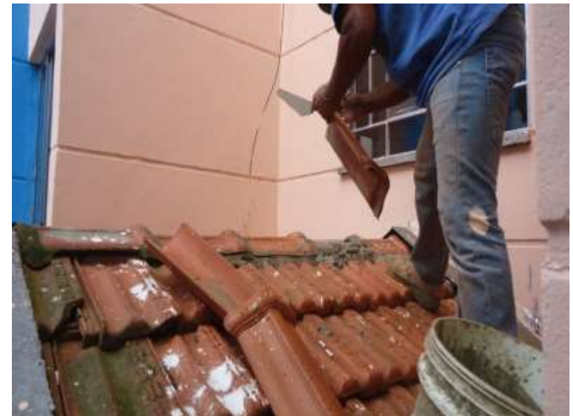
Parque Otero – Troca de telhas quebradas.
