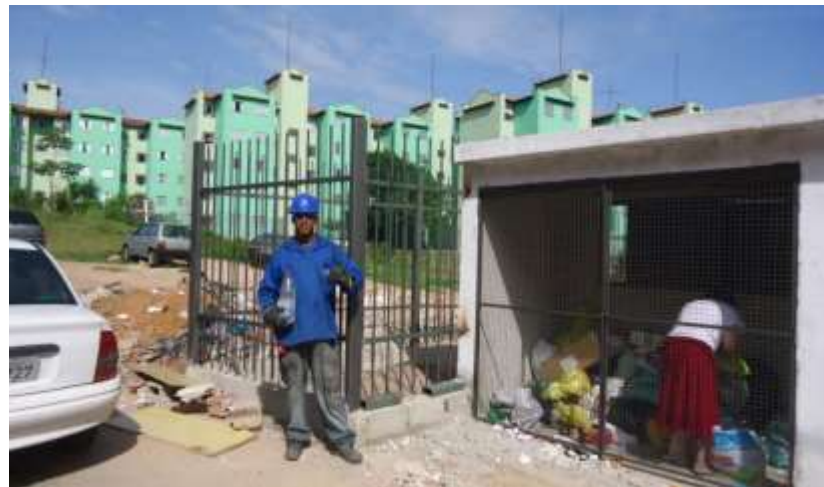
Parque Otero - Execução de lixeiras.
