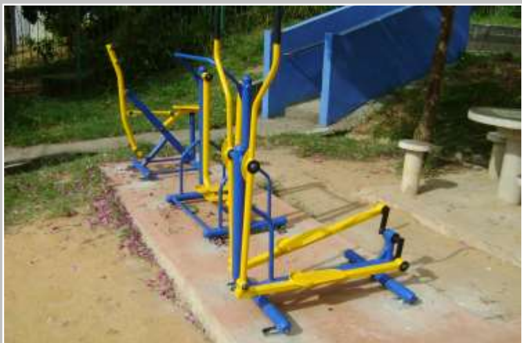
Instalação de equipamentos de ginástica
