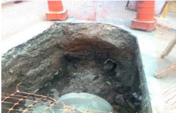
Rua Marcondes Buarque (Jaçanã / Tremembé): Demolição e escavação do PV existente – 18/11/2014
