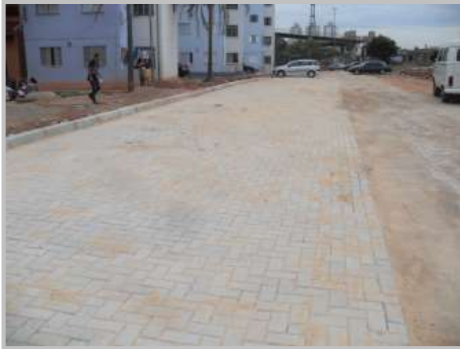
Pavimentação com piso intertravado – Condomínio 3
