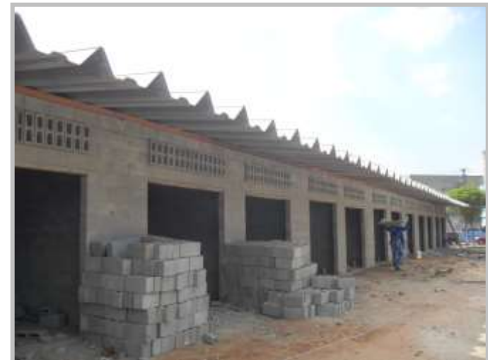
Execução da Cobertura – Centro Comercial – Fase 2
