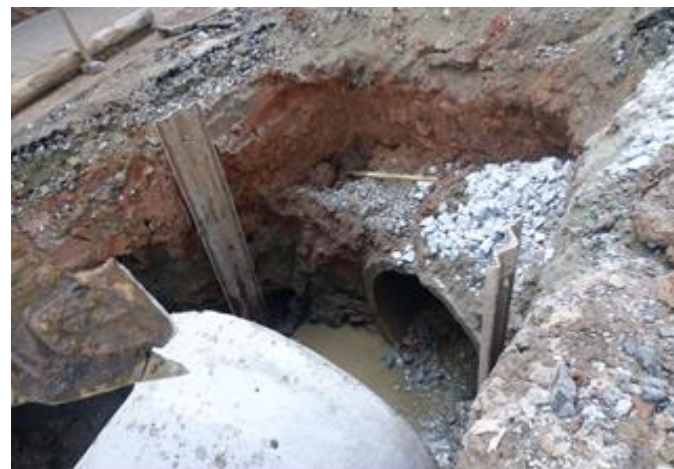
Assentamento de tubo do PV 23 ao PV 22 na Rua Brejo Novo – 21/11/2014
