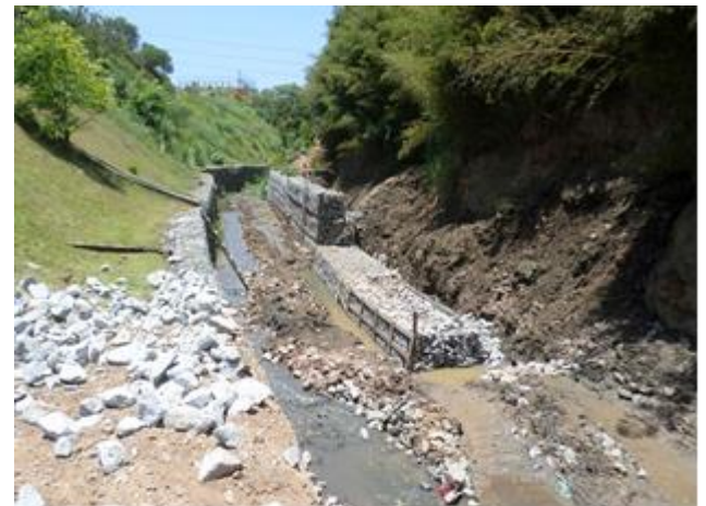
Av. Cipriano Rodrigues (depois): Execução de gabião margem direita – 21/11/2014
