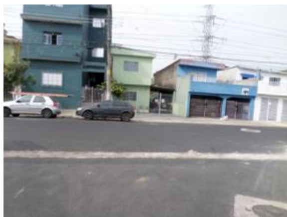
Sarjetão na R. Augusto Montenegro – Jaçanã / Tremembé - 21/11/14
