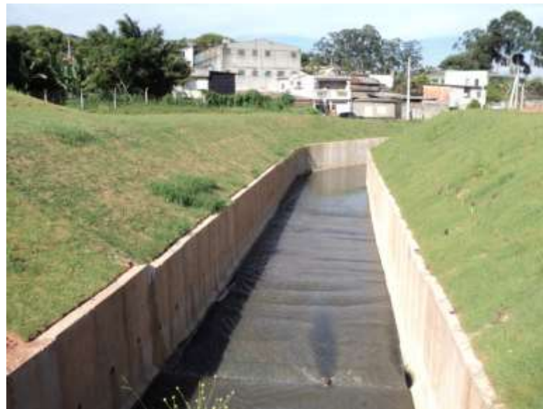
Cidade Júlia – Canalização Córrego Apucás
