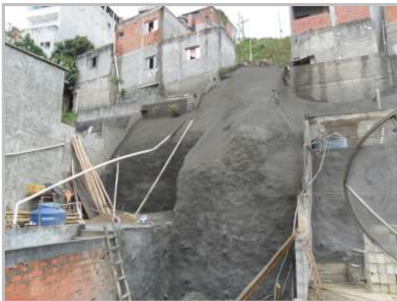
Execução do solo grampeado da Rua Faisão
