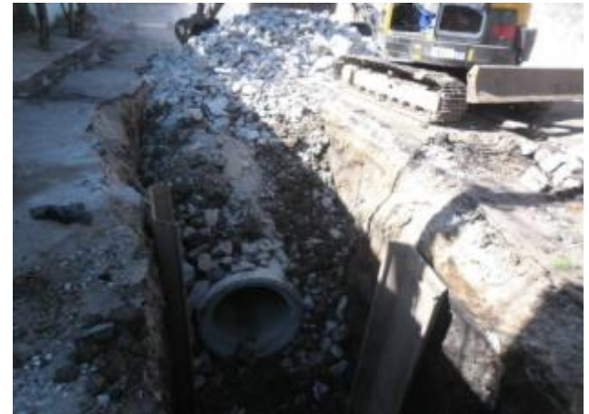
Rua Paulino Arena (Jaçanã / Tremembé): Execução da rede de drenagem – 12/11/14
