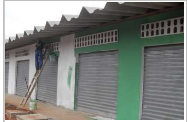
Acabamentos externos - Centro comercial – Fase 1
