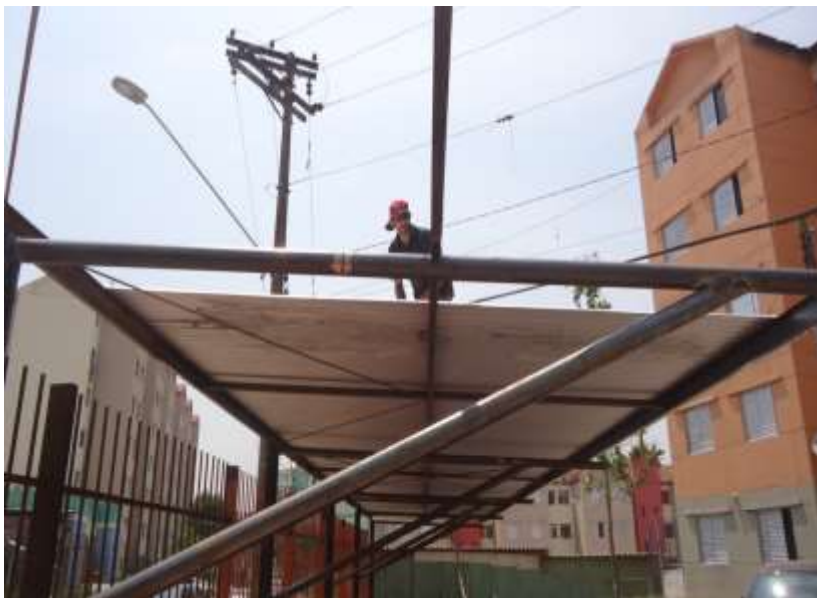
Jd. Arpoador – Cobertura do estacionamento.
