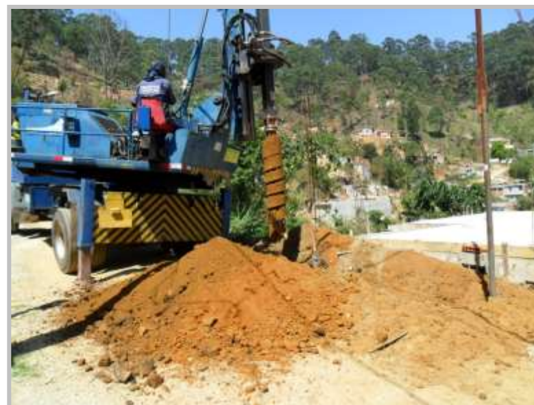
Execução da contenção da Rua Zabelê
