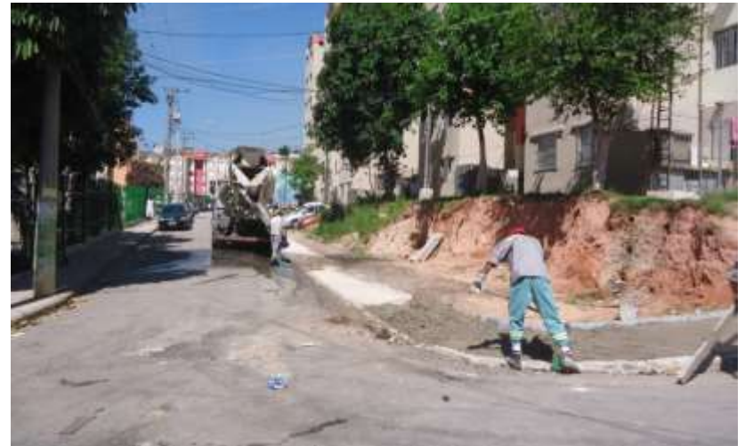
Jd. Arpoador – Execução de calçadas.
