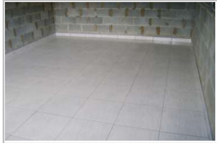
Colocação de pisos no Centro de Convivência
