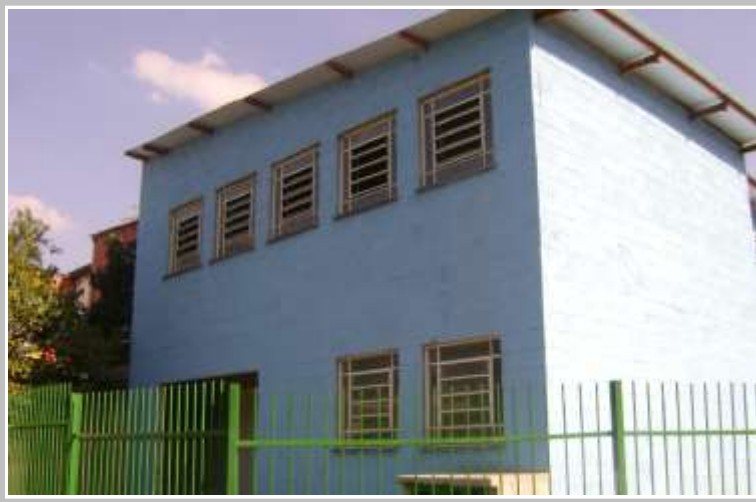
Pintura externa do Centro de Convivência
