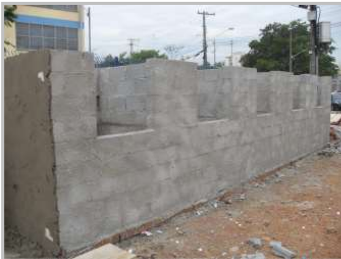
Alvenaria de elevação das lixeiras – Condomínio 4
