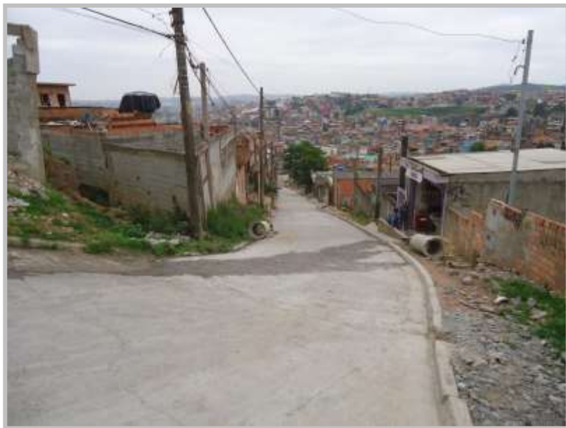
Execução da pavimentação – Rua Flamboyant
