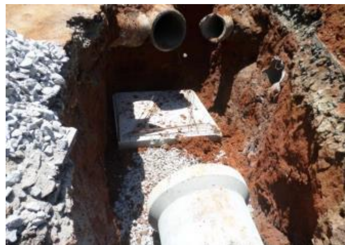
Rua Almir Alves de Souza: Laje de fundo do PV 18 na Rua Alfaro – 21/11/2014
